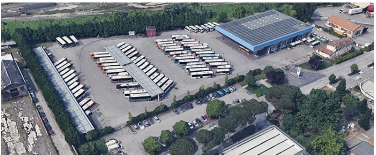
Figura 1 Deposito via Pandolfa 50-52, Forlì
