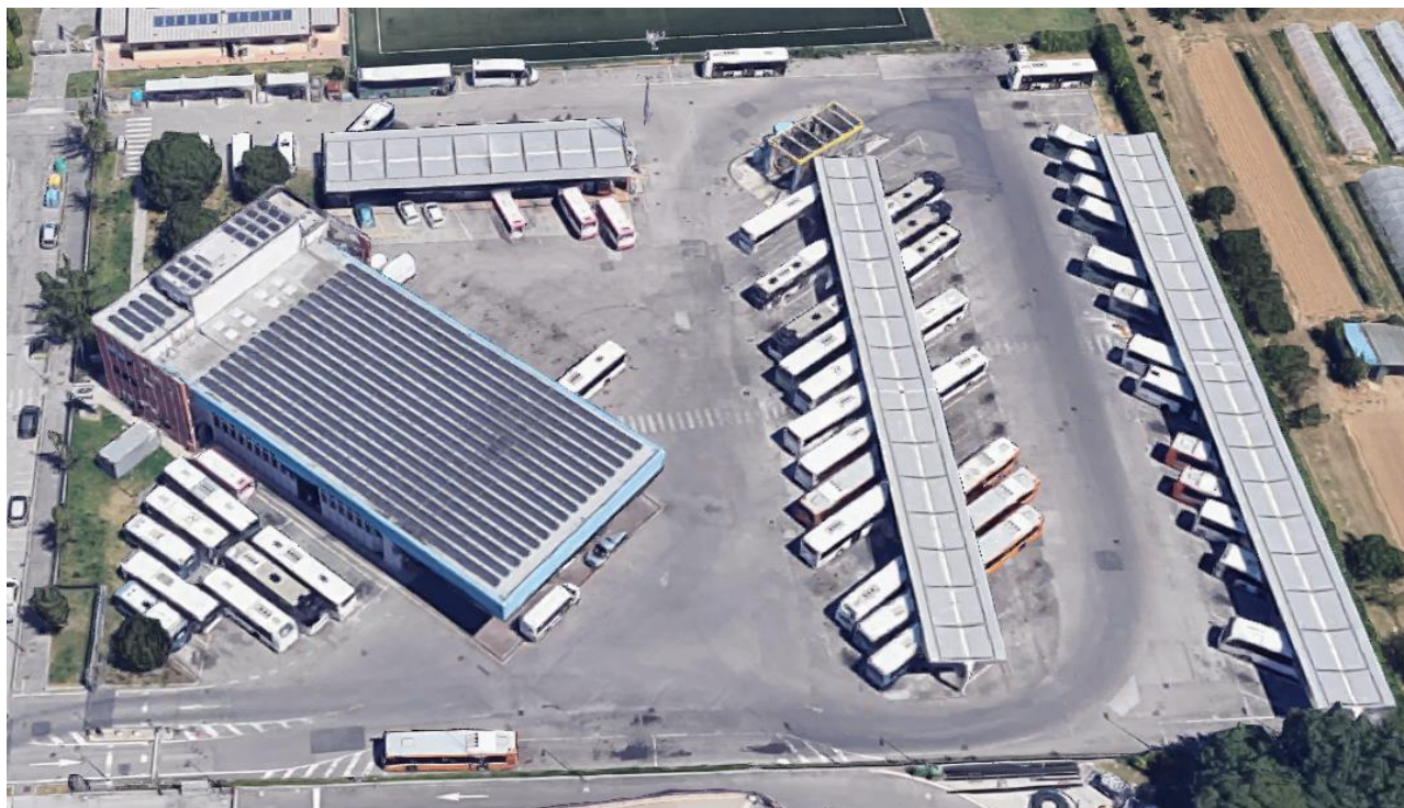
Figura 10 Deposito Cesena - Via Spinelli n. 140
