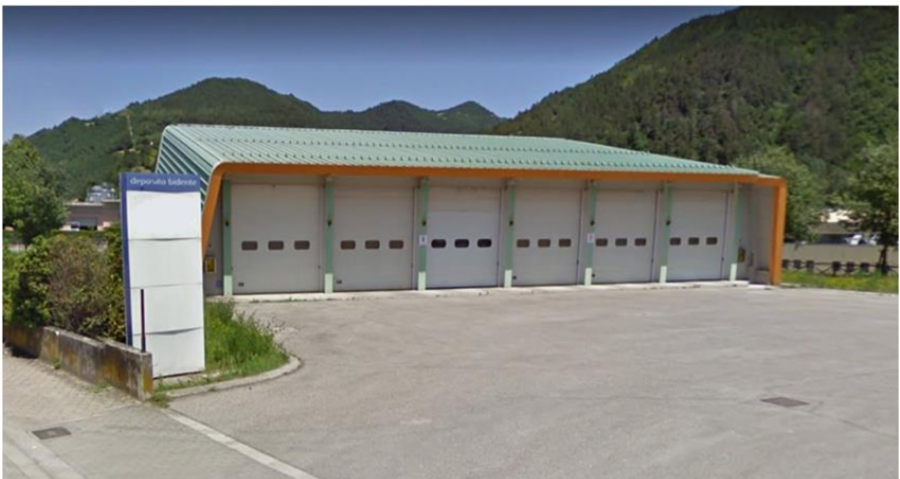
Figura 6 Deposito Santa Sofia - Via G. di Vittorio n. 16
